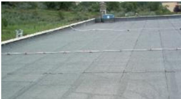
Distacco del manto da un piano di posa non adeguato: gli accavallamenti sono il risultato della scarsa resistenza del massetto sottostante in cemento cellulare a bassa densità.
